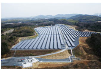
厚狭太陽光発電所
